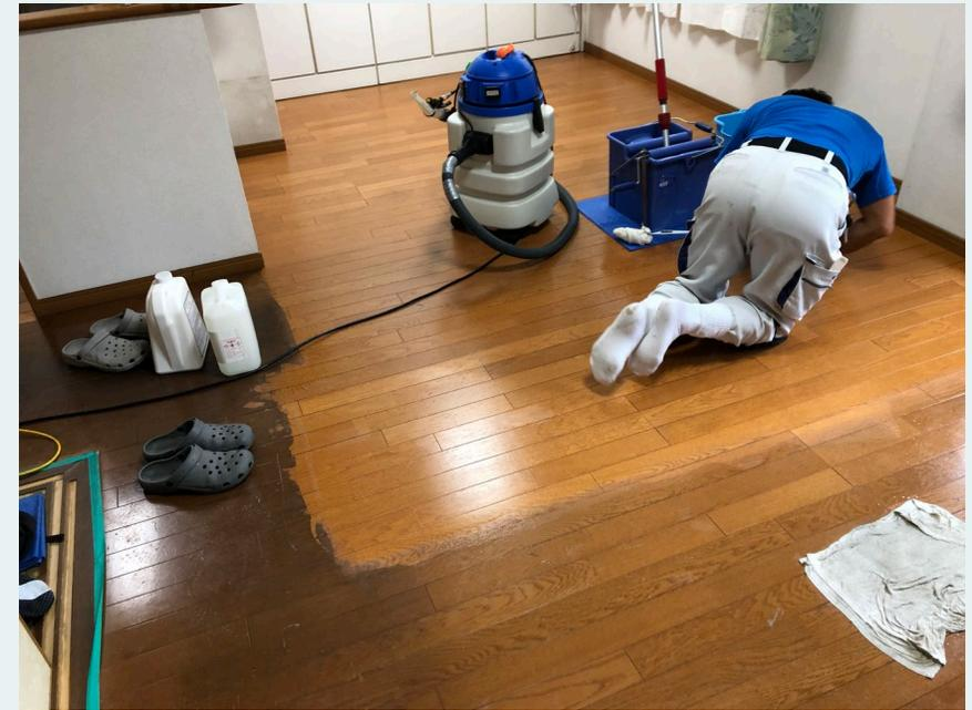
洗浄剤塗布 ➡ 液剤の引き延ばし ➡ 専用機材によるクリーニング ➡ ウェットバキューム
